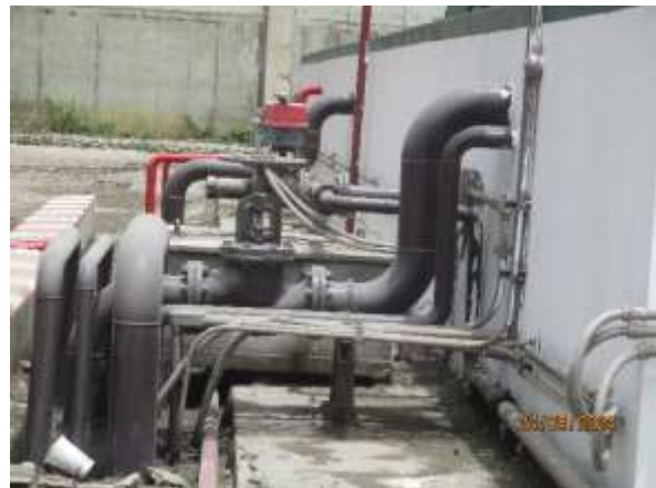
รูปที่ 9 ระบบถัง ท่อลำเลียงและอุปกรณ์สูญถ่ายของเสียที่เป็นของเหลว
